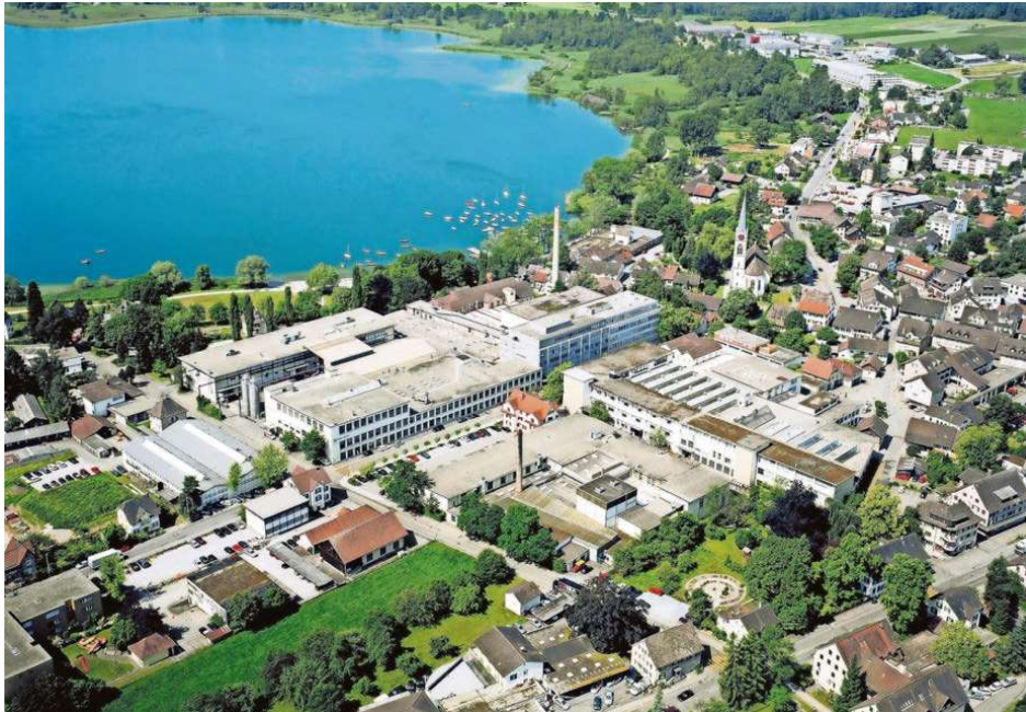
Das Areal Tumbelen Nord in Pfäffikon, hier eine Drohnenaufnahme aus dem Jahr 2016, wird in den nächsten Jahren frei. Foto: PD
