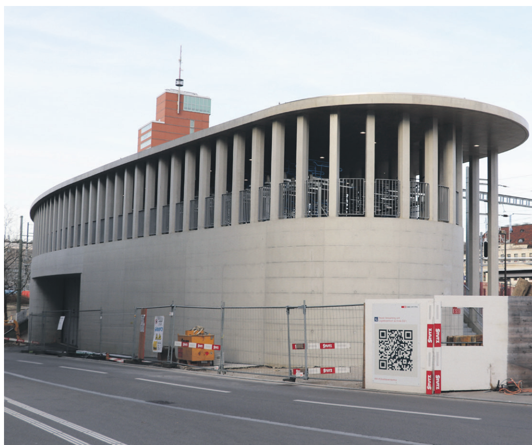
Mit der Velostation auf dem Esse-Areal entstehen 550 neue Abstellplätze für Fahrräder. mh
