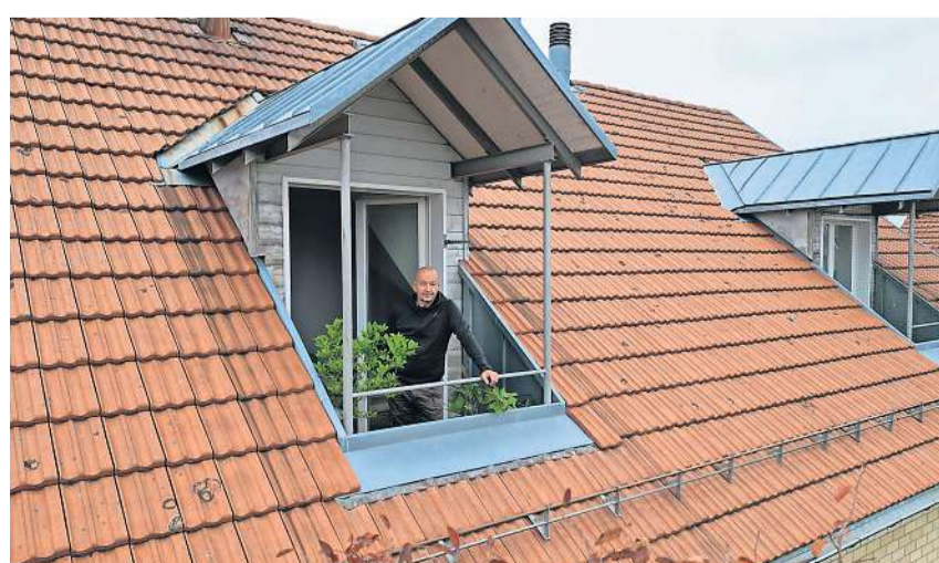
Auf diesem Balkon will der Vermieter keine Solaranlage.
