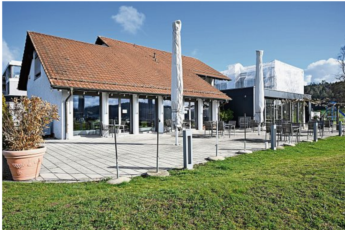
Vor allem hinter dem Restaurant Sporrer wird gebaut, aber auch im Lokal selber. Foto: Madeleine Schoder
