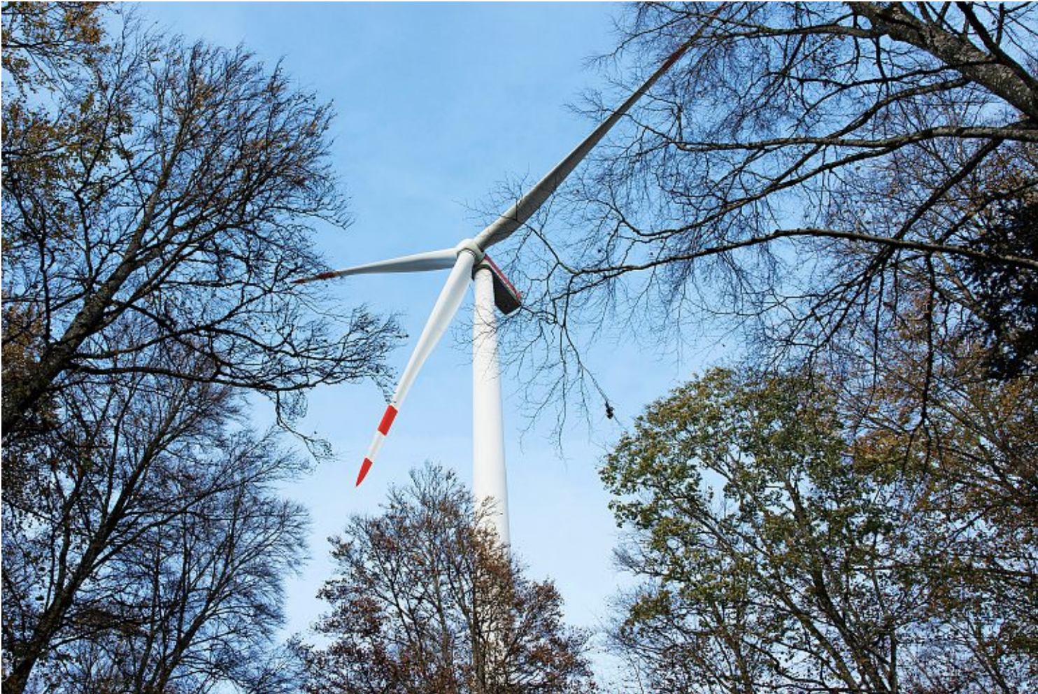
In Süddeutschland direkt an der Grenze zur Schweiz liegt der Windpark Verenafohren. Die drei knapp 200 Meter hohen Windräder produzieren seit neun Jahren Strom. Die Windverhältnisse sind ähnlich wie in der Region Winterthur. Foto: Dominique Meienberg
